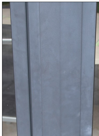
Zo ziet een profiel er uit na vijf jaar systematisch niet reinigen
