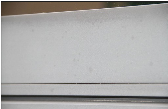
Opnieuw een profiel waarbij enkel de bovenrand (samen met het glas) werd gereinigd; het vuil vormt a.h.w. een film die de eigenschappen van coating langzaam aantast
